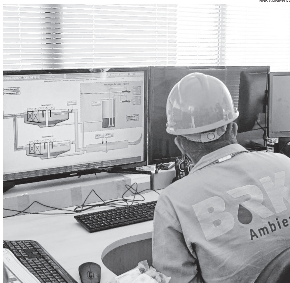
Equipes de operação da BRK Ambiental iniciaram processo de automação das EEEs
