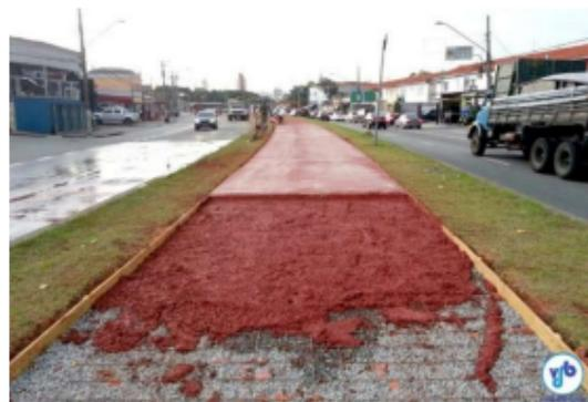
*Figura 2 - Ciclovia executada com concreto colorido.*
