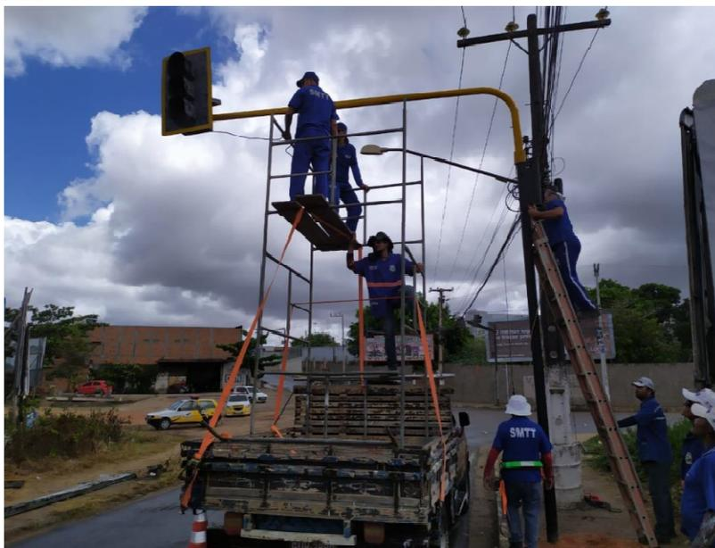
*Figura 109 - Equipe da SMTT conserta semáforo danificado após acidente de veículo na R. Pedro II*
