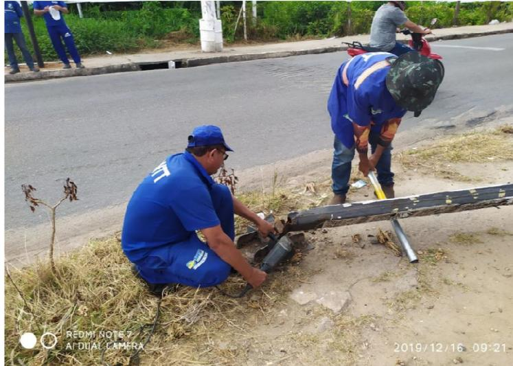
*Figura 110 - Técnicos da SMTT substituem base danificada de semáforo na Rua Pedro II*
