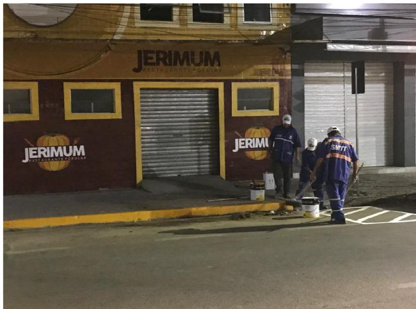
*Figura 106 – Implantação de marca de canalização e sinalização vertical de proibido estacionar*
