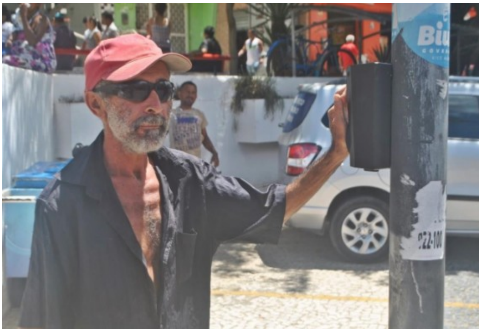
Figura 17: botoeira para deficientes visuais. Fonte: arquivo próprio
