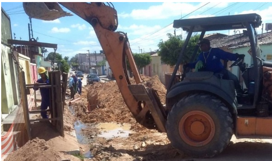
Foto 1 – Implantação de Rede Coletora de Esgoto
