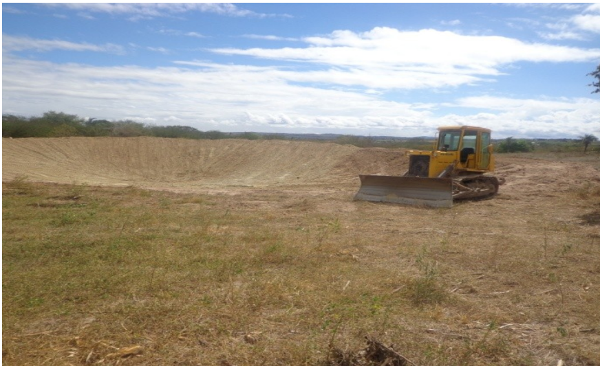
Construção de aguadas
