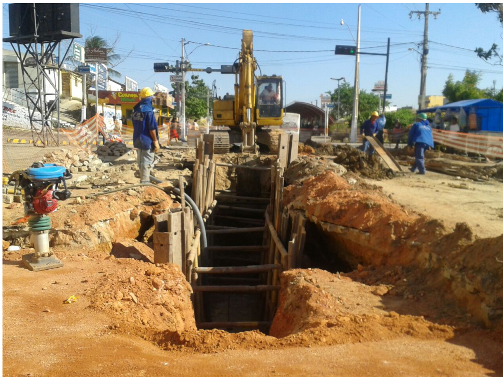
Foto 4 – Implantação do Coletor Tronco
