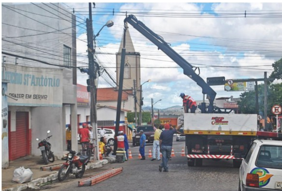
Figura 16: SMTT conserta semáforos em bairros de Arapiraca. Fonte: arquivo próprio
